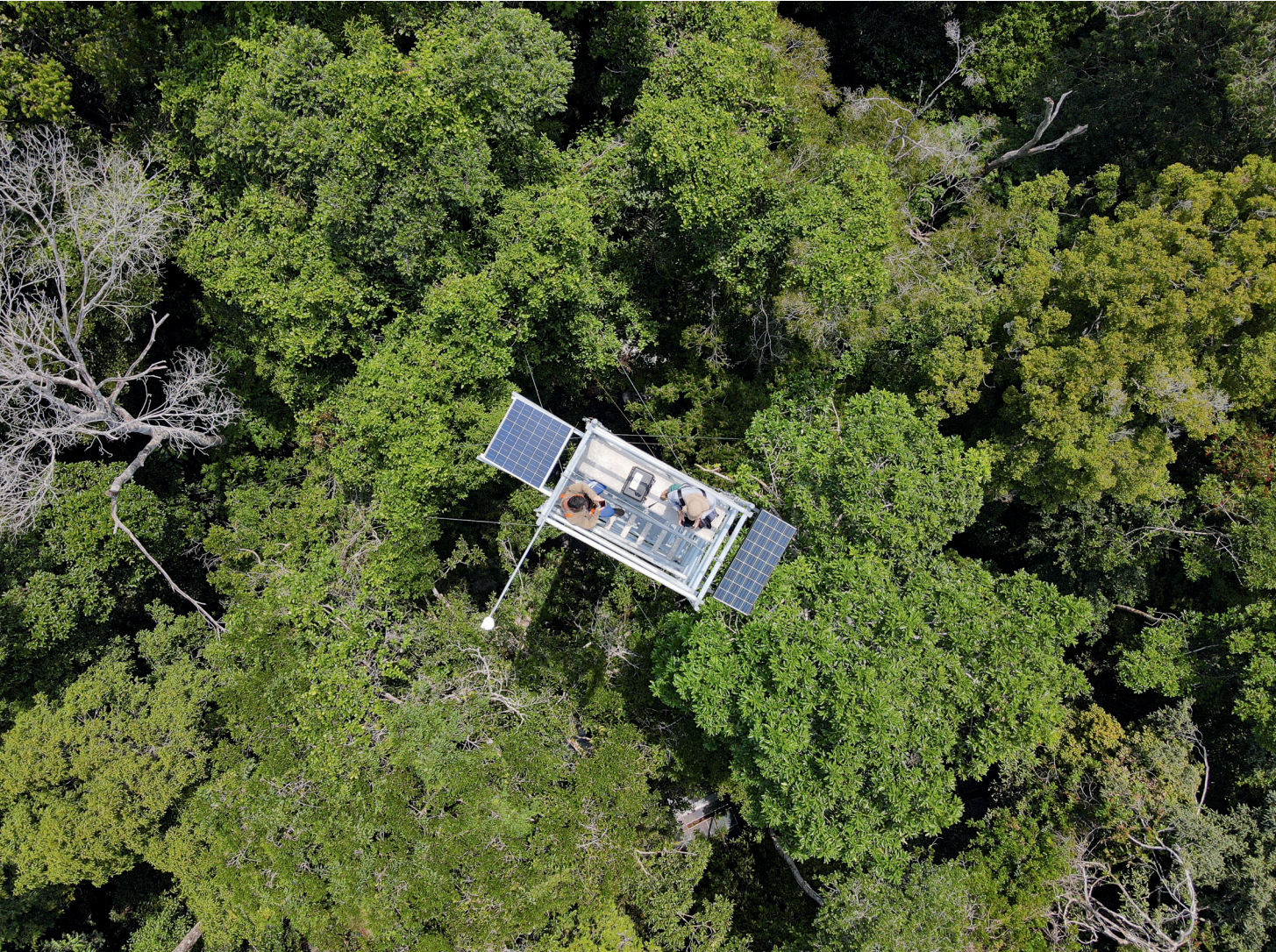
Vista aérea da torre de observação da Estação Científica Ferreira Penna, Melgaço, Marajó, 2022 Foto: Caill Torres/Esecaflor
